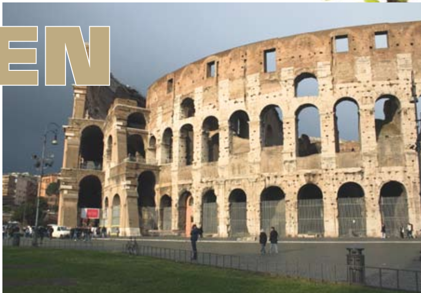
Colosseum, dåtidens superarena, står kvar än idag, med lite hjälp av Napoleon. Han lät bygga strävpelare för att hindra att valven rasade.
