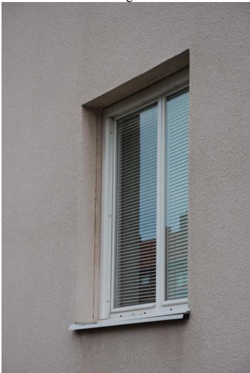
Figur 8.13 Fönsterparti, fastigheten Hösten (Malmö) efter tilläggsisolering av fasad.
