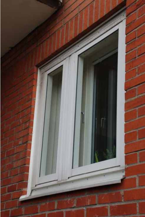
Figur 8.23 Fönsterparti, fastighet på Persborg (Malmö) efter tilläggsisolering av fasad.
