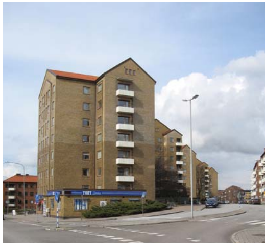
Figur 6.9 Fasader, fastighet kv. Munken i Helsingborg.
