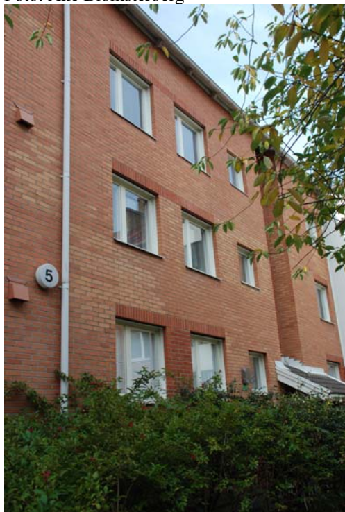
Figur 8.25 Taksprång, fastighet på Persborg (Malmö) efter tilläggsisolering av fasad.
