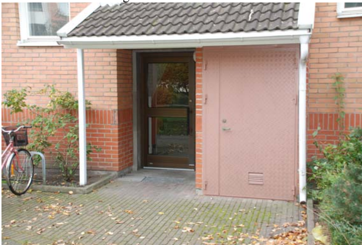
Figur 8.22 Helt nya entrépartier, fastighet på Persborg (Malmö) efter tilläggsisolering av fasad.
