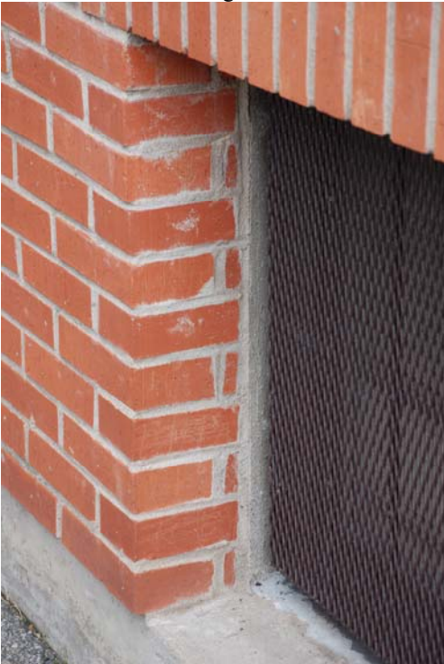
Figur 8.24 Källarväggsparti, fastighet på Persborg (Malmö) efter tilläggsisolering av fasad.
