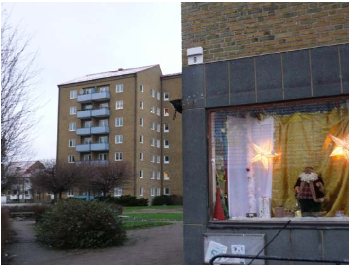
Figur 6.7 Fasader, fastighet Sandvången i Landskrona.
