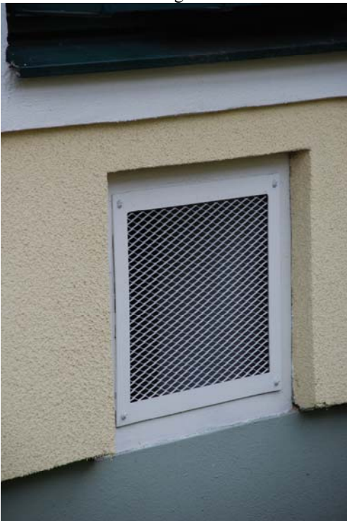
Figur 8.4 Källarfönster, Brf Ryttmästaren (Malmö) efter tilläggsisolering av fasad.
