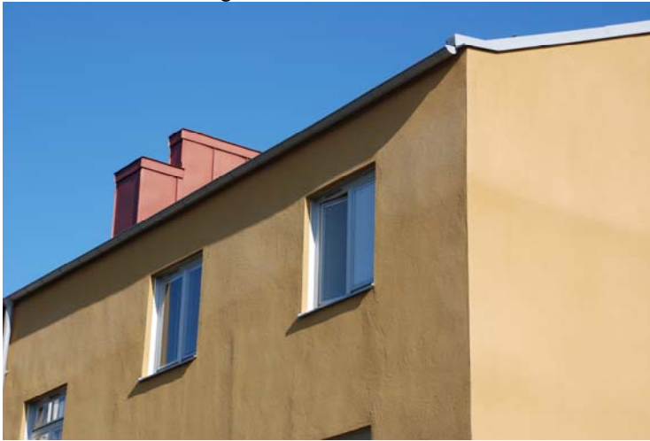
Figur 8.11 Taksprång, brf Huggaren (Malmö) efter tilläggsisolering av fasad.
