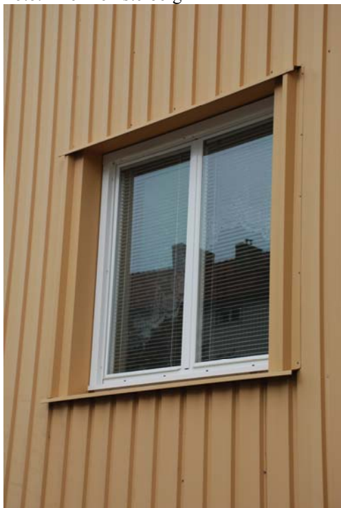
Figur 8.20 Fönsterparti, fastighet på Augustenborg (Malmö) efter tilläggsisolering och ny plåtfasad.
