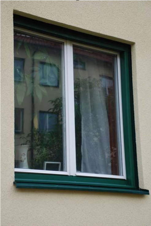
Figur 8.3 Fönster, Brf Ryttmästaren (Malmö) efter tilläggsisolering av fasad.
