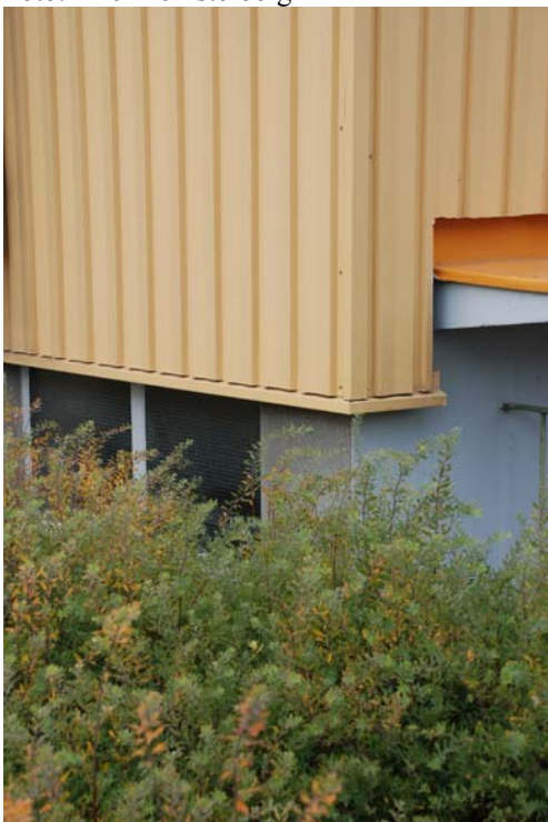
Figur 8.19 Källarvägg, fastighet på Augustenborg (Malmö) efter tilläggsisolering och ny plåtfasad.
