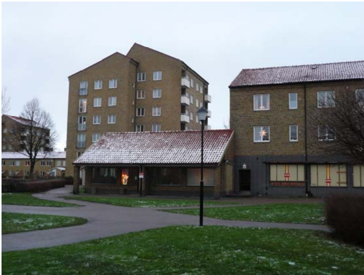
Figur 6.6 Fasader, fastighet Sandvången i Landskrona.
