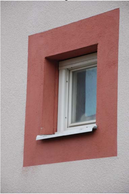
Figur 8.14 Fönsterparti, fastigheten Hösten (Malmö) efter tilläggsisolering av fasad.
