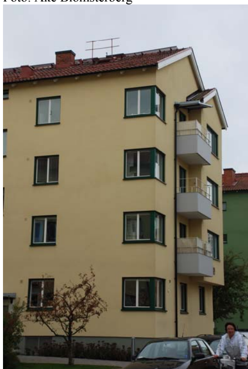
Figur 8.6 Brf Ryttmästaren (Malmö) efter tilläggsisolering av fasad. Taksprånget finns fortfarande kvar till stor del.
