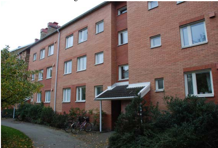
Figur 8.21 Fastighet på Persborg (Malmö) efter tilläggsisolering av fasad.
