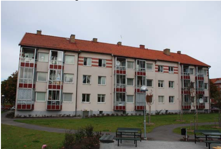
Figur 8.12 Fastigheten Hösten (Malmö) efter tilläggsisolering av fasad.
