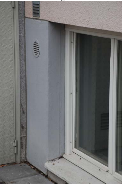
Figur 8.15 Källarvägg, fastigheten Hösten (Malmö) efter tilläggsisolering av fasad.
