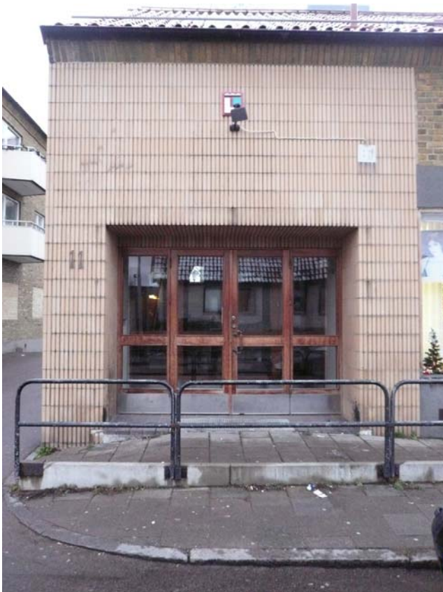
Figur 6.8 Entréparti, fastighet Sandvången i Landskrona.
