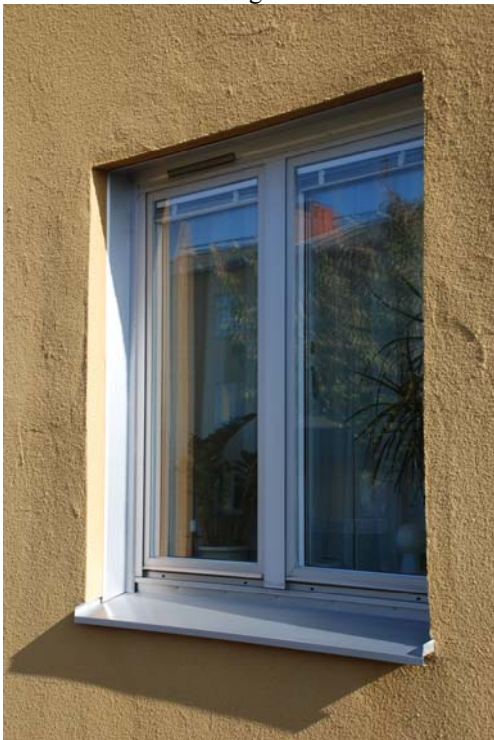
Figur 8.9 Fönsterparti, brf Huggaren (Malmö) efter tilläggsisolering av fasad.
