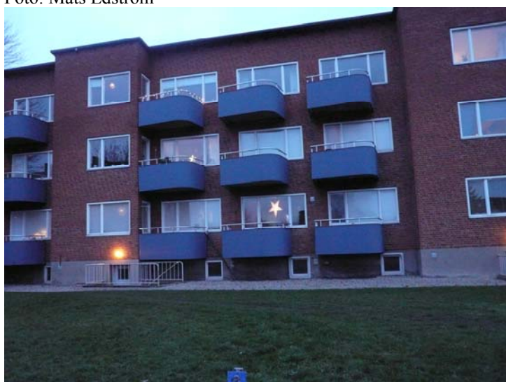
Figur 6.4 Fasader, fastighet Borgmästaregården i Lund.
