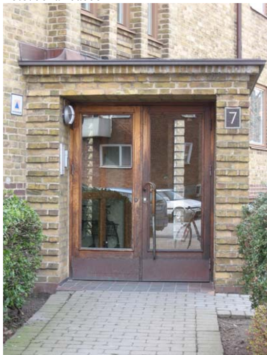
Figur 6.11 Entréparti, fastighet kv. Munken i Helsingborg.
