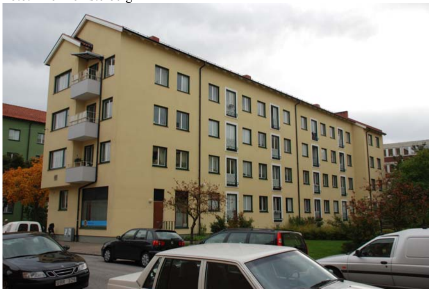
Figur 8.1 Brf Ryttmästaren (Malmö) efter tilläggsisolering av fasad.
