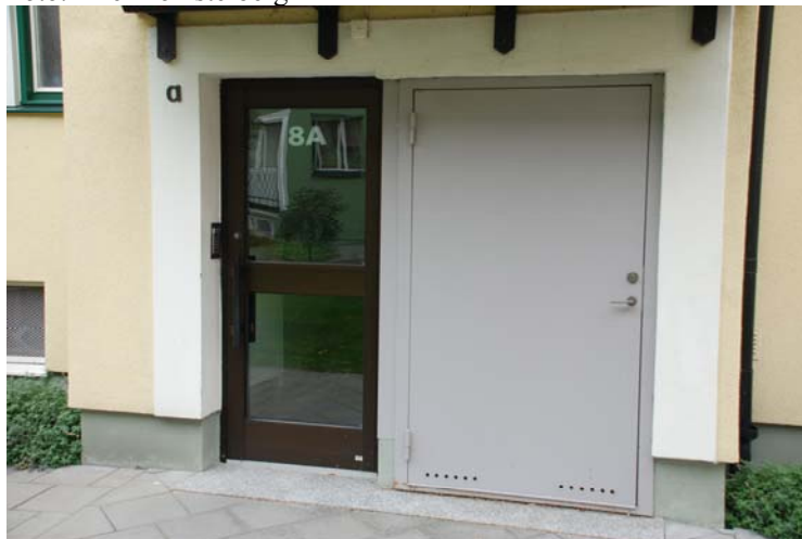
Figur 8.5 Entréparti, Brf Ryttmästaren (Malmö) efter tilläggsisolering av fasad.
