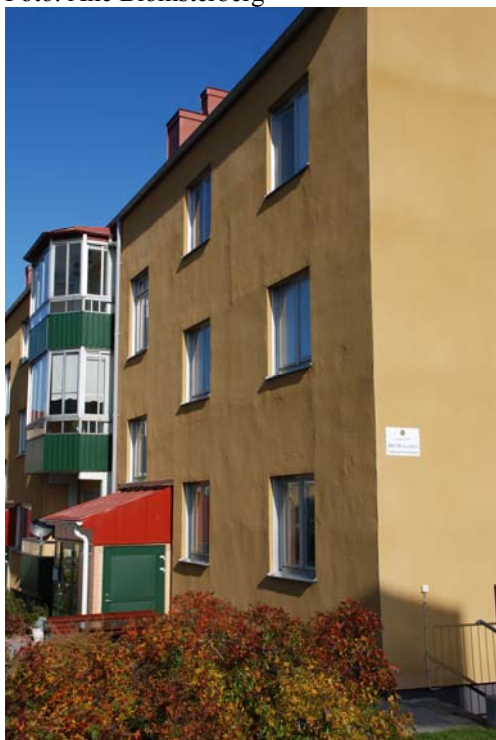
Figur 8.8 Brf Huggaren (Malmö) efter tilläggsisolering av fasad.
