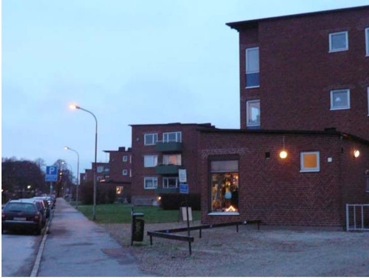
Figur 6.5 Fasader, fastighet Borgmästaregården i Lund
