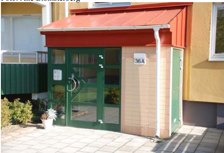
Figur 8.10 Helt nya entrépartier, brf Huggaren (Malmö) efter tilläggsisolering av fasad.
