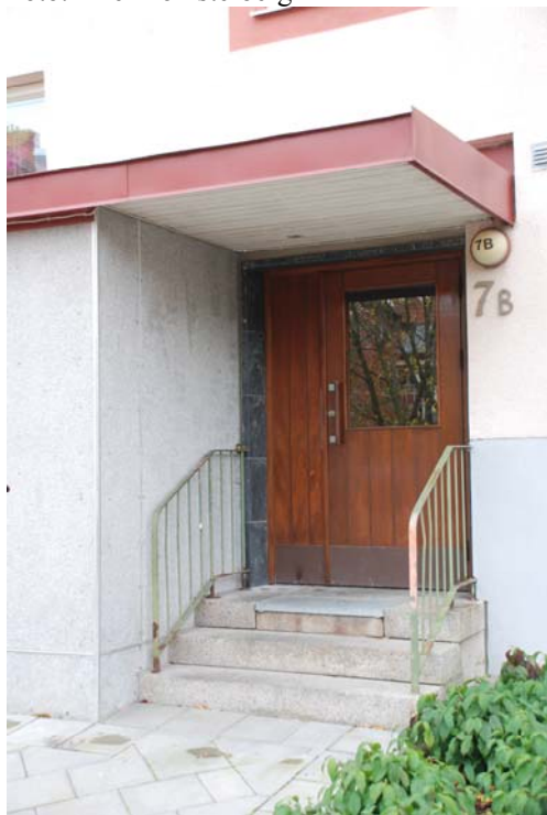
Figur 8.16 Delvis nya entrépartier, fastigheten Hösten (Malmö) efter tilläggsisolering av fasad.
