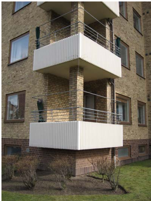
Figur 6.10 Balkonger, fastighet kv. Munken i Helsingborg.
