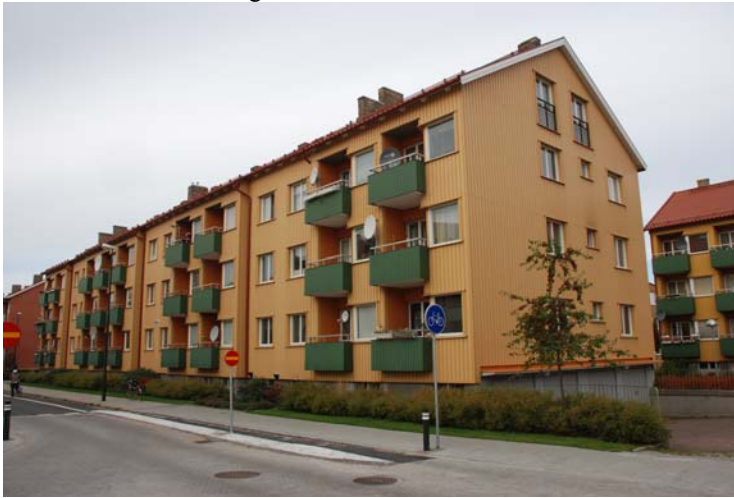
Figur 8.18 Fastigheten på Augustenborg (Malmö) efter tilläggsisolering och ny plåtfasad.
