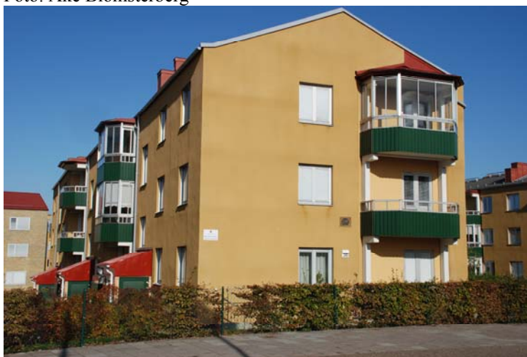
Figur 8.7 Brf Huggaren (Malmö) efter tilläggsisolering av fasad.
