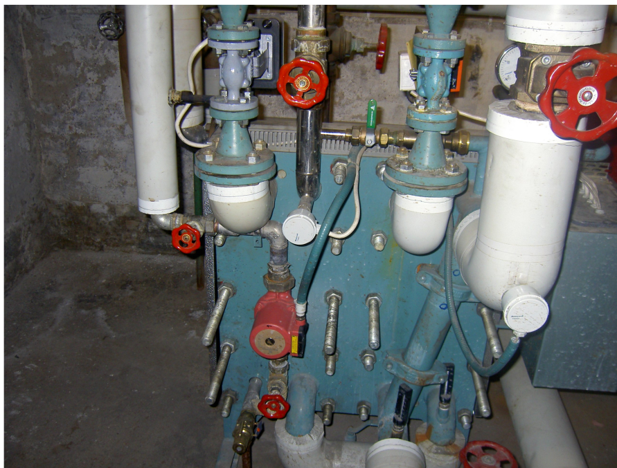
Figur 4.3. Värmeväxlare på David Hallstorg 10 för fjärrvärme till både varm- och varmvatten [eget material].
