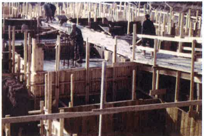
Maskinteknik, Gjutning av supergolvfundament, mars 64.
