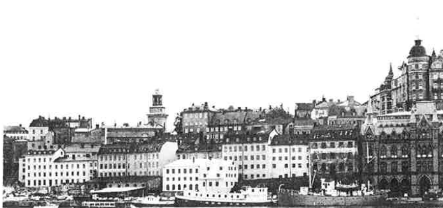
Bild 2. Området mot norr under pågående restaurering, sett från Riddarholmen, år 1972.
