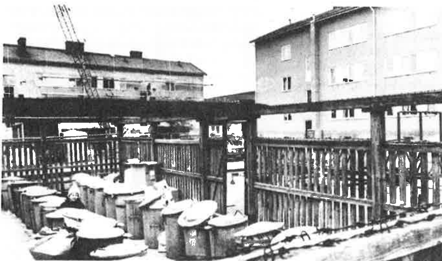
Bild 2. Området före och under moderniseringen. Gården.
