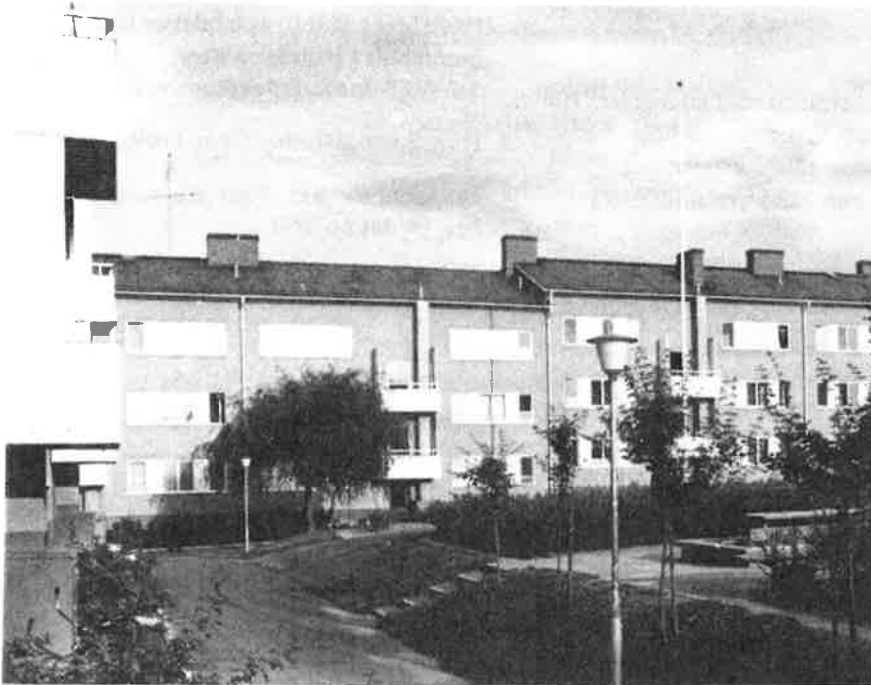
Bild 3. Området efter moderniseringen. Gården 1972. Huset i fonden är byggnaden mot Hagagatan.
