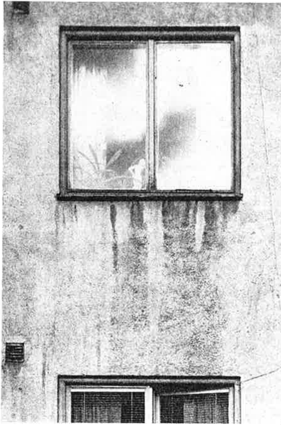
Ovan och nedan: Fig. 3 och 4. Del av fasad före och efter beklädnaden. Som även framgår av fig. 7, detalj 10 är friskluftsventilerna överklädda. Friskluften tas in från luftspalten bakom beklädnaden
